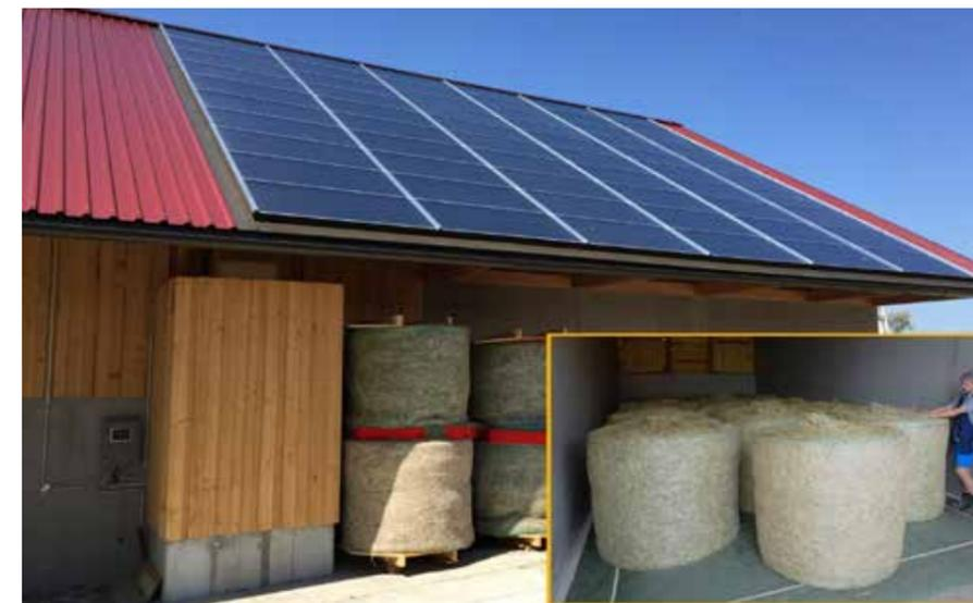
Solare Hackschnitzel-, Heu- und Getreidetrocknung bei der Kompostieranlage Schnellberger in Wartberg/Kr.
