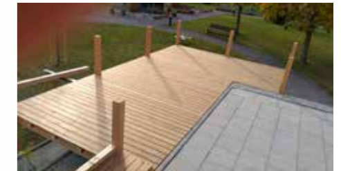
Die neue Terrasse für den Kindergarten im Altenheim
