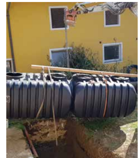
Beispiel für eine Regenwasserzisterne mit 10 000 Litern – gleichzeitig beinahe der virtuelle Wasserverbrauch für 2 Tage für eine Person
